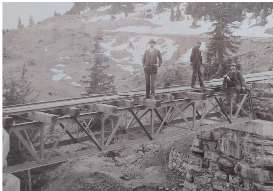
Foto 6: Kleine spoorbrug in aanbouw bij de smalspoorbaan Grütschalp – Mürren.
