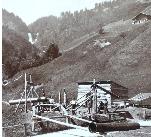
Fig.4. Aanleg van de buisleiding in Arosa.
